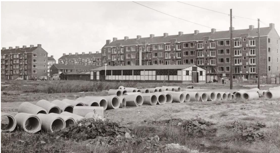
De buurt in aanbouw. Augustus 1954. Beeldbank Amsterdam.
